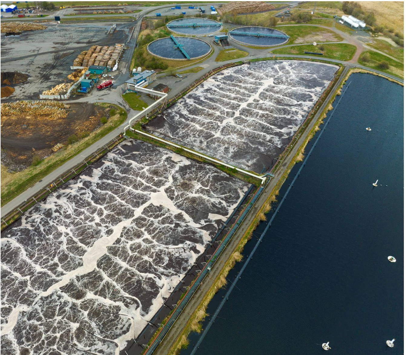
Aktivslamanläggningen för biologisk rening av avloppsvattnet.
